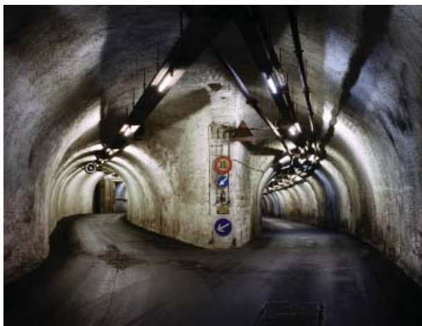
9 Deutschland (West), Lorch, Versorgungslager der Bundeswehr in einem Atomschutzbunker, Lorch 2008 © Martin Roemers
